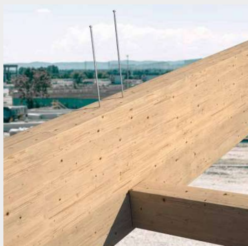
Rinforzo ortogonale alla fibra per carico appeso dovuto a giunzione trave principale-secondaria.
